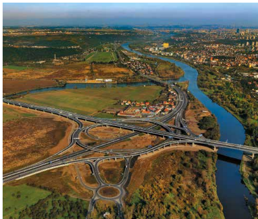
Dálniční přemostění nad soutokem Vltavy a Berounky před Prahou
