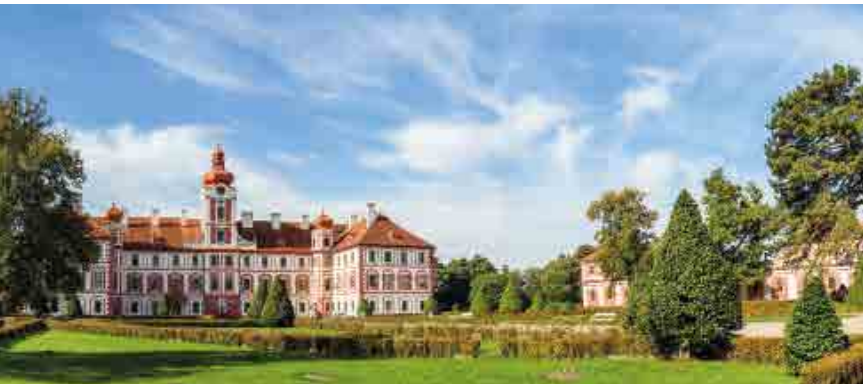
Zámek Mnichovo Hradiště
